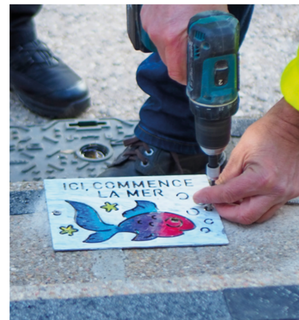
Pose des plaques réalisées par le CMJ dans le cadre du projet "Ici commence la mer"
