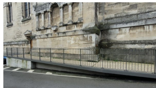
Mise en accessibilité de l'église
